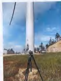
8 号风机 南侧测点处
