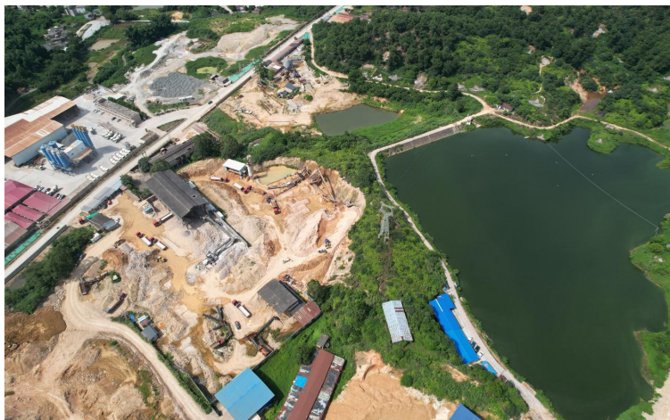
项目东面山塘、东北面丰顺县润江再生资源有限公司
