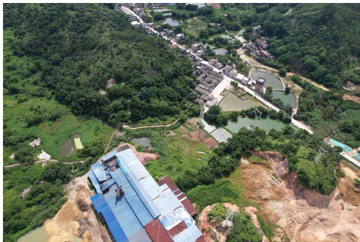
项目北面山林地、西面山林地
