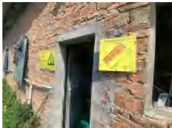
危废贮存设施标志牌及分区标志
