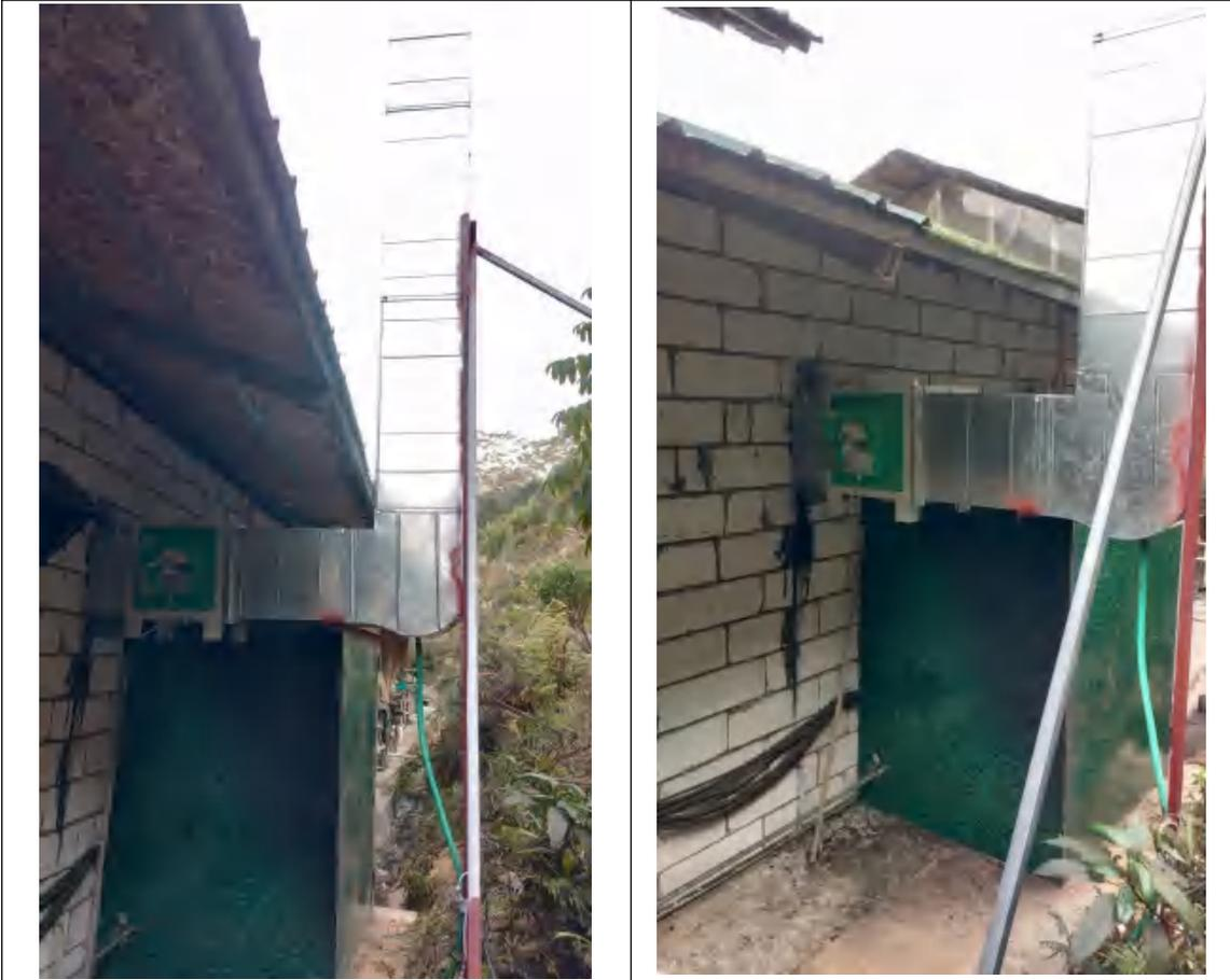
静电油烟净化器+排气管
